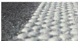
**Spot Flex** è stato inventato originariamente per la termoplastica in Danimarca ed è anch'esso un agglomerato molto comune per la marcatura a freddo in Europa centrale. Le "gocce" di plastica fredda sono normalmente più piccole e più arrotondate rispetto alle linee termoplastiche "drop-on-dot". Ma la funzionalità è uguale/simile: buon drenaggio, effetto sonoro e perline di vetro protette sul lato dell'agglomerato.
